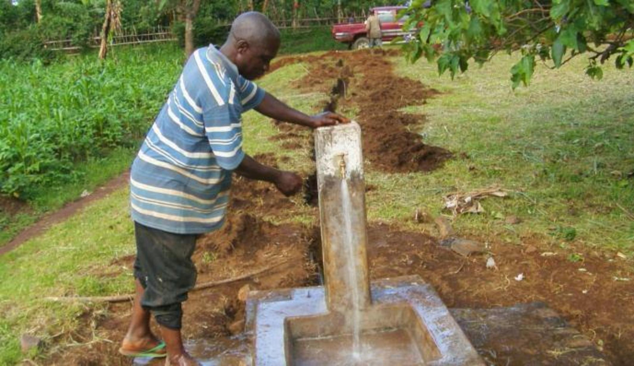
Erster Test des Netzwerks um undichte Stellen zu identifizieren
